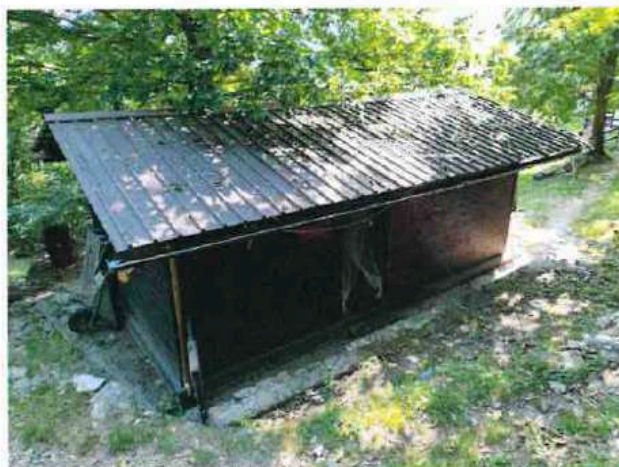
4 - Vista basso fabbricato " custode " da area esclusiva
