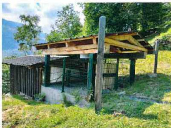
5 - Vista tettoia teleferica da area esclusiva
