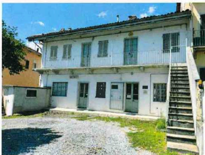
1 - Vista fabbricato principale dal cortile
